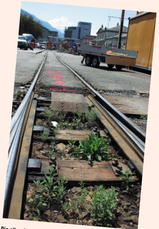
Die alten Gleise haben ausgedient. Hier kommt der Bustraminial zu stehen.
