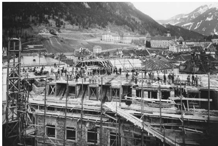
Auch heute noch ein stattlicher Bau: die Graubündner Kantonalbank von Otto Schäfer und Martin Risch.
