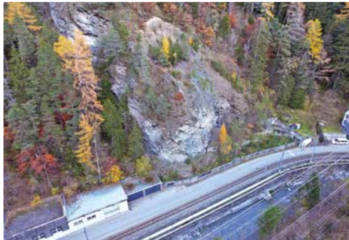
Die Strasse in Richtung Meiersboden soll ausgebaut werden.
