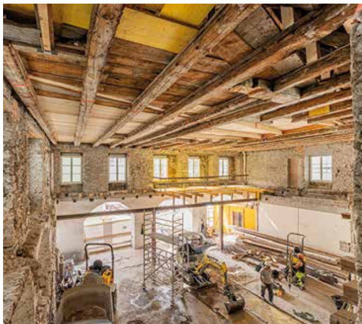
Bei den Ausgrabungen im Haus am Arcas sind Teile der alten Stadtmauer gefunden worden. (Bild zVg)
